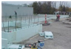
Béton de construction (préfabriqué et armé)
