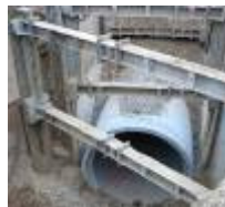
Béton de réseau
