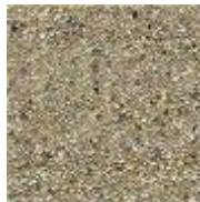
Béton de trottoir et dalle en béton
